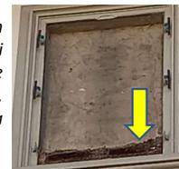
**CORNICIONE CORRENTE:** Gli spazi tra le travi, spesso sono coperti da pannelli di tamponamento (legno, laterizio intonacato) con fessure e discontinuità che se sono di almeno 3x6 cm permettono ai rondini di entrare negli spazi retrostanti per nidificare. Le colonie che usano questi siti sono numerosissime. In alcuni casi durante lavori da noi seguiti le fessure sono state rispettate, o migliorate o sostituite con aperture ad hoc.
